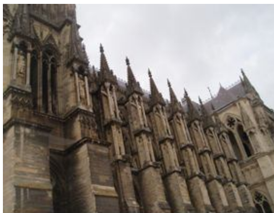
Μαύρη κρούστα σε κάθετες επιφάνειες πωρόλιθου που δεν αποπλένονται από τη βροχή. Η περιοχή είχε έντονη
