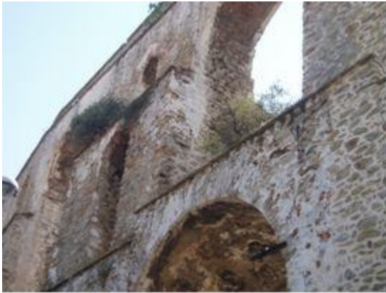
Οι Καμάρες πριν τις επεμβάσεις συντήρησης, με τα άσχετα επιχρίσματα, μαύρες κρούστες και φυτά.
