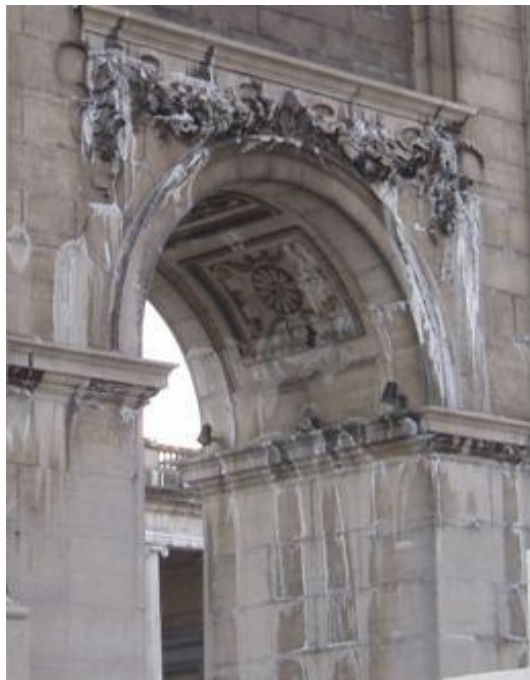
Λευκές κρούστες από ανακρυστάλλωση αλάτων γύψου. Αψίδα Πεντηκονταετίας, Βρυξέλλες, Βέλγιο
