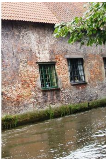
Κυψέλωση στο 1/3 του ύψους πλίνθινης τοιχοποιίας της οποίας η βάση είναι σε συνεχή επαφή με νερό. Κτίσμα στο κεντρικό κανάλι της Μπρυζ-Βέλγιο
