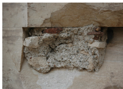
Μάρμαρο με συγκολλήσεις τσιμεντοκονάματα και μεταλλικά στοιχεία. Από τις επεμβάσεις αποκατάστασης της ομάδας Ν. Μπαλάνου στα Προπύλαια (Ακρόπολη Αθηνών)
