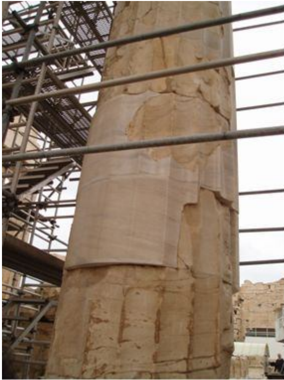
Αναστηλωμένος κίονας στη βόρεια όψη του Παρθενώνα
