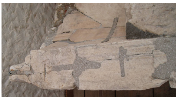
Μάρμαρο με συγκολλήσεις τσιμεντοκονάματα και μεταλλικά στοιχεία. Από τις επεμβάσεις αποκατάστασης της ομάδας Ν. Μπαλάνου στα Προπύλαια (Ακρόπολη Αθηνών)
