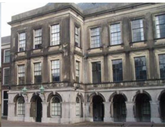
Μαύρη κρούστα, από νεκρά μικροβιακά κύτταρα μικροοργανισμών στην επιχρισμένη επιφάνεια, σε σημεία
