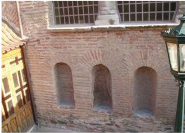
Ιερός Ναός Αχειροποιήτου Θεσσαλονίκης. Ο καθαρισμός της πλινθοδομής έγινε με αμμοβολή.
