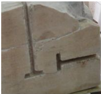
Λάξευση στο μάρμαρο για τοποθέτηση συνδέσμων. Στην εν εξελίξει συντήρηση των μνημείων της Ακροπόλεως η ΥΣΜΑ χρησιμοποιεί συνδέσμους από τιτάνιο υλικό υψηλής αντοχής στην οξείδωση και διάβρωση
