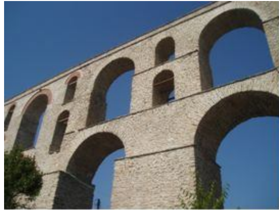
Ανάδειξη του μνημείου μετά τον καθαρισμό, την αντικατάσταση των σαθρών κονιαμάτων και τη στερέωση.
