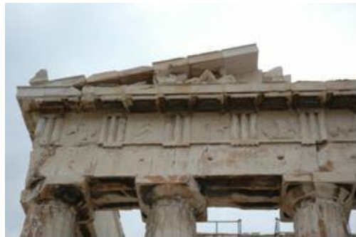
Παρθενώνας: προσθήκες ευδιάκριτες στα άκρα από συμβατό υλικό για τις ανάγκες διδακτικής κατανόησης του μνημείου, χωρίς να παραμορφώνει τη σημασία του ή να προκαλεί κιβδηλεία.
